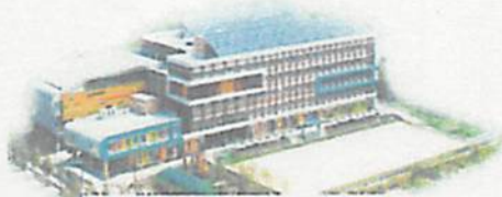
仁川松一小学校全景
